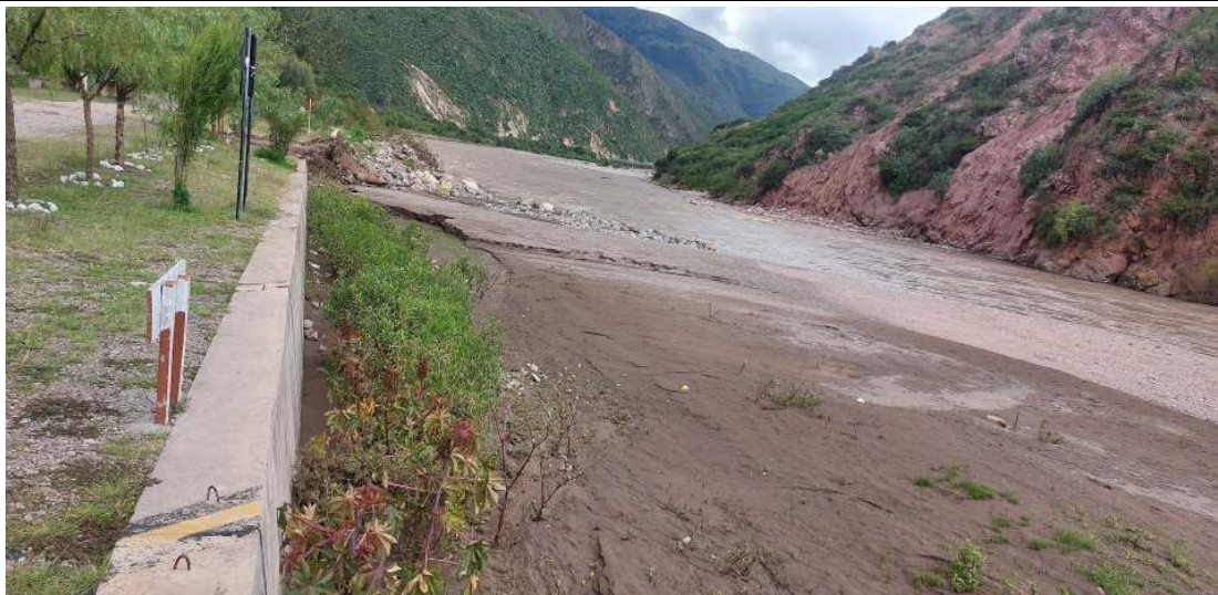
FOTOGRAFIA N 01: Se aprecia la margen izquierda que se encuentra colmatada y una superficie libre de 0.50m del muro de concreto armado, y que en épocas de máxima avenida es rebasado por el caudal del río Pampas se requiere de descolmatación
