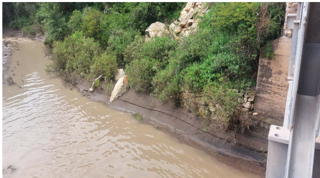
FOTOGRAFIA N 02: Se aprecia el cauce en la margen izquierda que afectó el talud y que este se encuentra adyacente a la vía que comunica con las otras provincias del sur del departamento de Ayacucho y la afectación a la estructura del puente.
